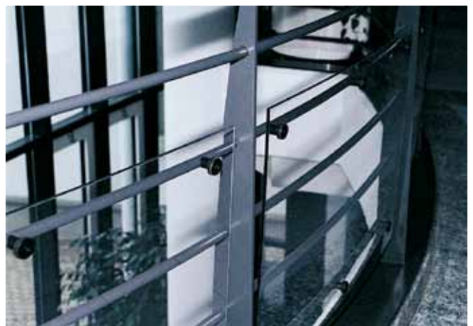
Sicherheitsglas auf der Innenseite, Höhe 75 cm: durch Schliessen der Öffnungen wird das Beklettern verhindert
