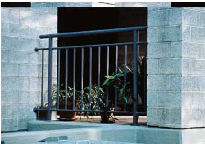
Transparente Variante: vertikale Stäbe und abgesetzter Handlauf auf einer Höhe von 100 cm, keine Öffnung grösser als \varnothing 12 cm
