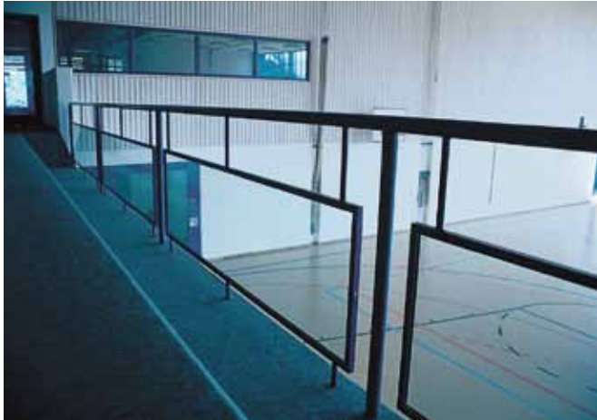
Absturzsicherung einer Zuschaueranlage mit Verbundsicherheitsglas, freie Sicht auf die Spielfelder, bis auf eine Höhe von 75 cm keine Öffnung grösser als Ø 12 cm
