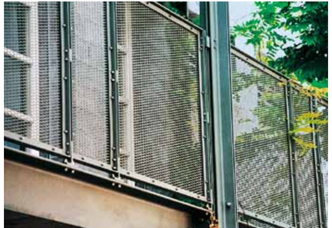
Balkongeländer mit einer Streckmetall-Füllung: in Metallfassung eingerahmt und an eine Primärkonstruktion montiert, keine Öffnung grösser als \varnothing 12 cm
