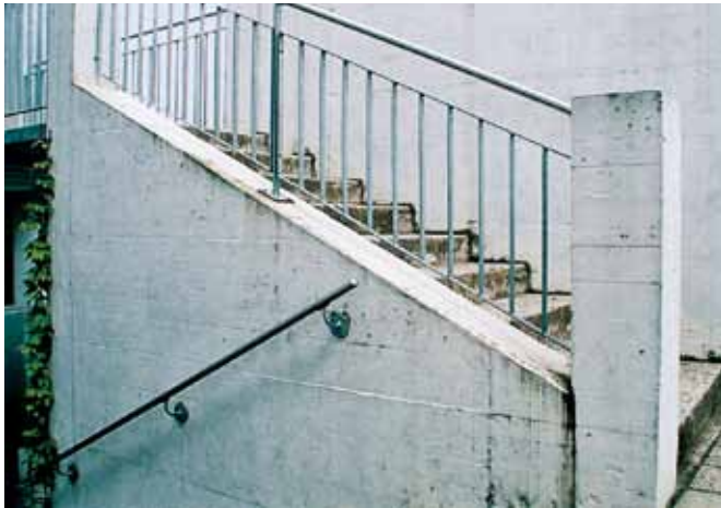
Treppen mit mehr als 5 Tritten: Handlauf zur Unterstützung beim Gehen, Staketengeländer als Absturzsicherung
