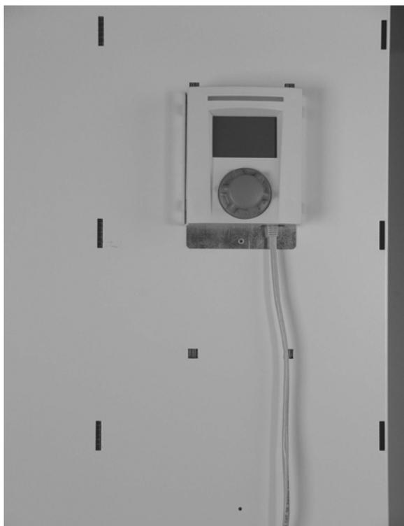
Pour cela décrocher d'abord le cache de la platine principale. Dévisser ensuite la vis inférieure de l'élément de commande et le dégager des deux évidements carrés de la façade.
